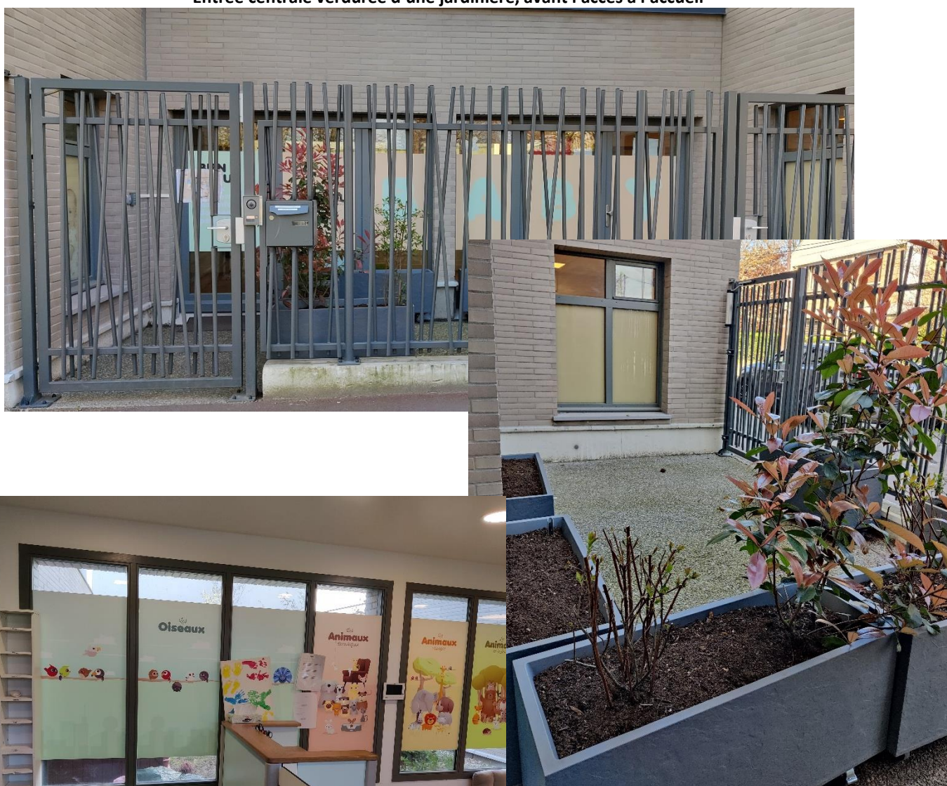
Entrée centrale verdurée d'une jardinière, avant l'accès à l'accueil
